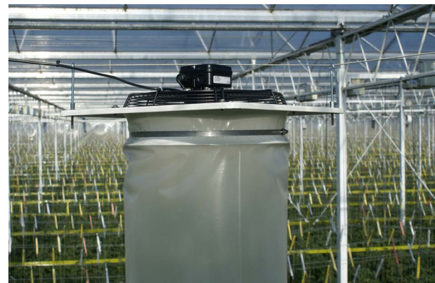
Verti-Fan® ophangen aan een rvs staalkabel
