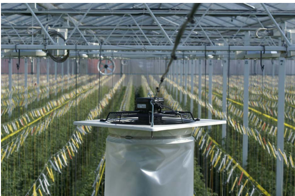
Verti-Fan® ophangen aan een rvs staalkabel
