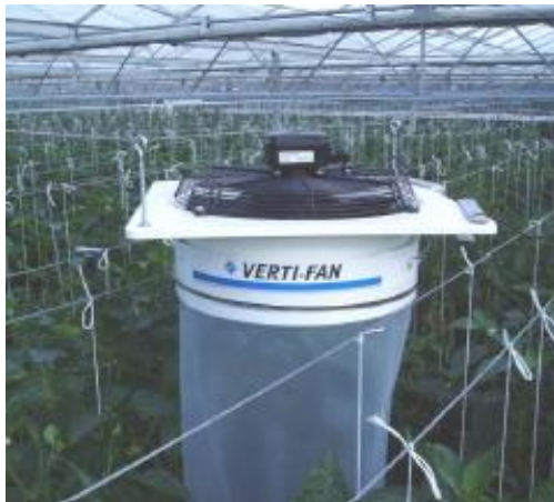
Afbeelding 3: Verti-Fan met kabel montage
