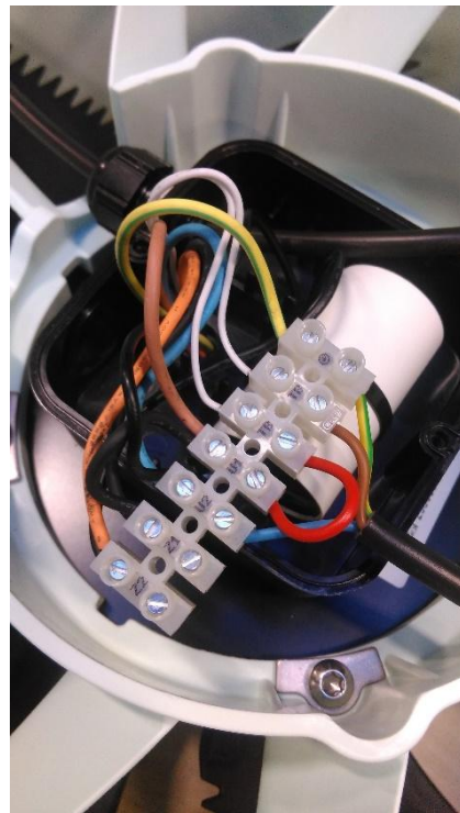
Figuur 12 Aansluiting Thermisch contact
