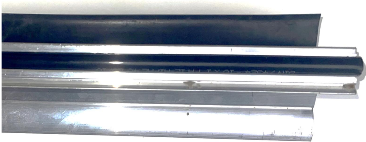
Figuur 21 Nylon slang ter bescherming van steundraden
